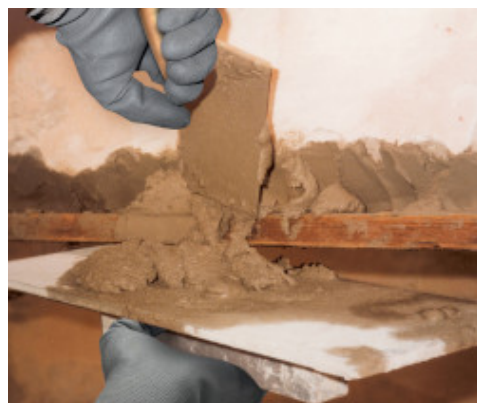
Ripristino di frontalini di balconi: applicazione di Planitop 400
