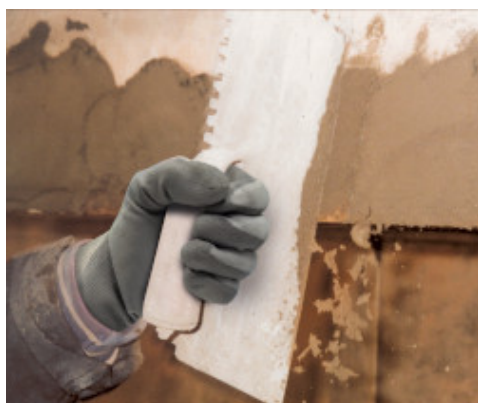
Ripristino di frontalini di balconi: finitura
