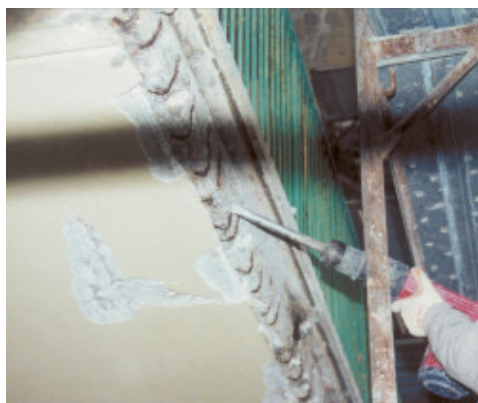
Ripristino di frontalini di balconi: preparazione del supporto
