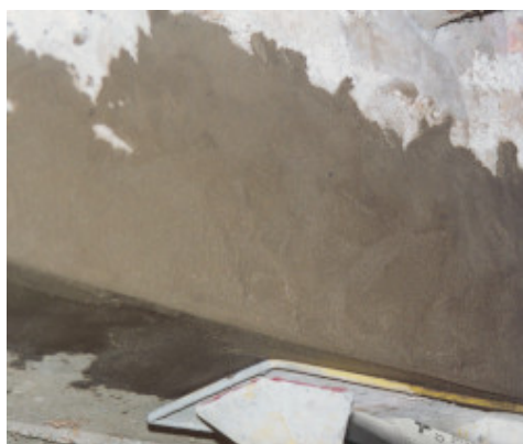
Ripristino localizzato di una trave in calcestruzzo
