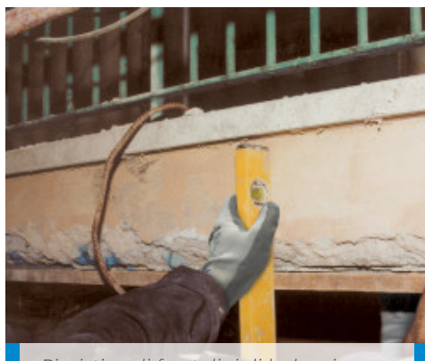
Ripristino di frontalini di balconi: posizionamento di sponda di contenimento
