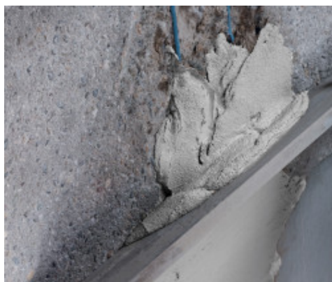
Staggiatura di Planitop Rasa & Ripara Zero
