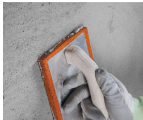
Frattazzatura di Planitop Rasa & Ripara Zero
